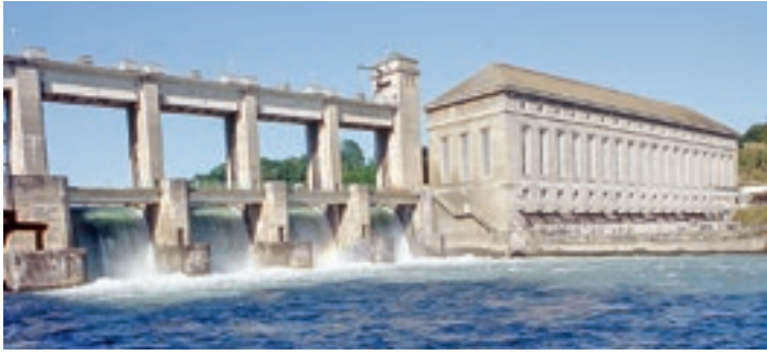
Le barrage de Chancy-Pougny, certifié naturemade star . Sa production atteint 240 GWh soit l'équivalent de la consommation de 70 000 ménages.
